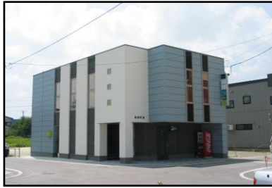
H18年度 KDビル 新築工事
