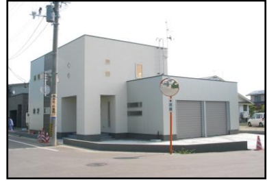
H18年度 OM邸 新築工事
