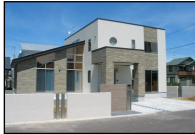
H19年度 TK邸 新築工事
