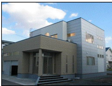
H17年度 ST邸 新築工事
