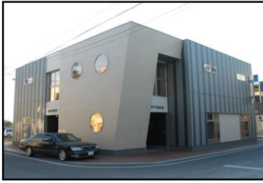
H18年度 第2TKビル 新築工事
