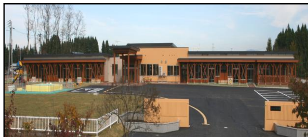
H19年度 よつば保育園 新築工事
