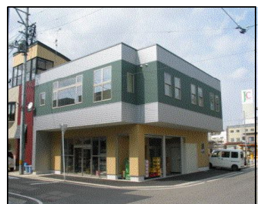
H18年度 TK邸 新築工事
