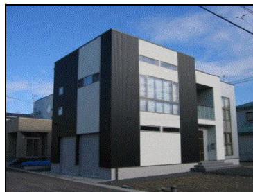
H17年度 IT邸 新築工事
