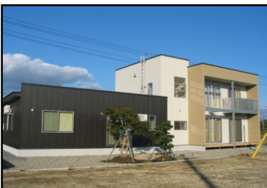
H19年度 ST邸 新築工事
