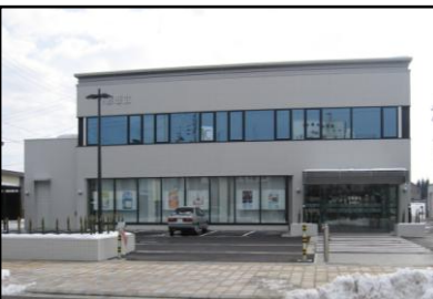
H19年度 (株)北都銀行 新築工事(JV)
