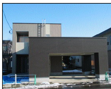
H18年度 UT邸 新築工事
