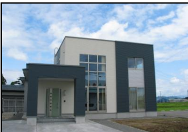
H19年度 FK邸 新築工事
